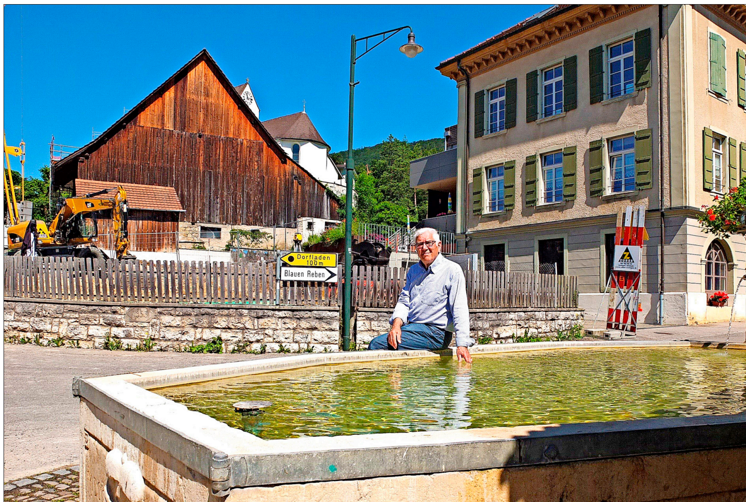
Dieter Wissler am Dorfbrunnen. Dahinter das umgebaute Schulhaus und die Baustelle für das neue Begegnungszentrum.
