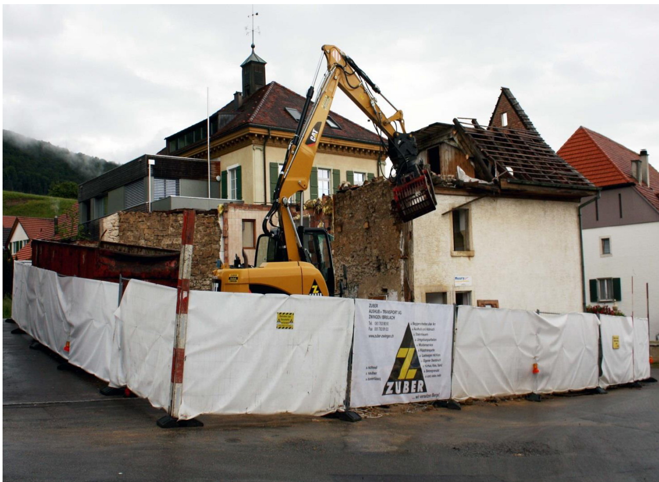
Abbruch Bucherhaus, Dorfstrasse 13 (Foto Lukas Ambühl)
